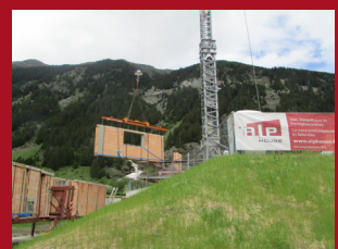
Montage der Fertigwände
