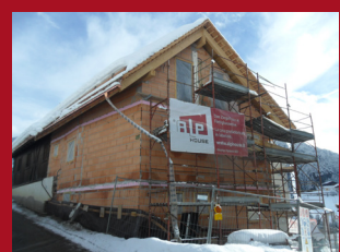
Rohbau mit Dach
